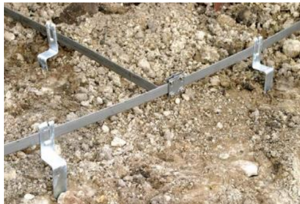
Ringerder aus Bandstahl V 4 A Quelle: www.dehn.de
